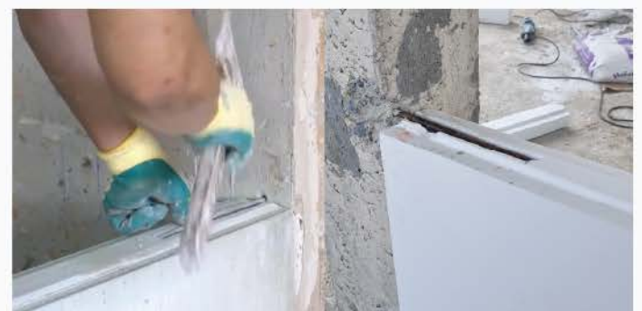
เสริมความแข็งแรงด้วยเหล็กหมวดกึ่ง
