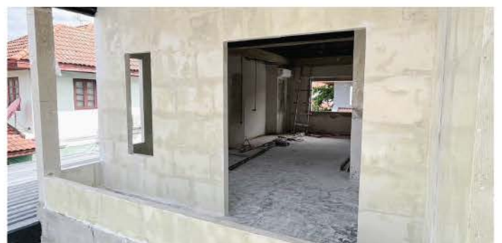
ใช้น้ำยา Rocky Coat ทาเพื่อกันซึม
