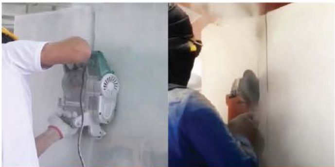
สามารถใช้เครื่องเจาะร่อง หรือลูกหมูกรีดผนังได้
