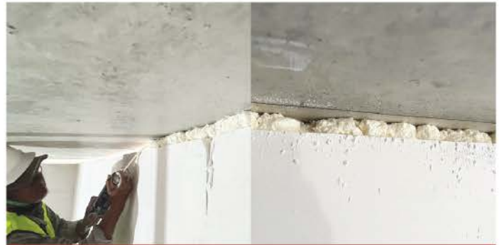
เก็บช่องว่างด้วย PU FOAM
