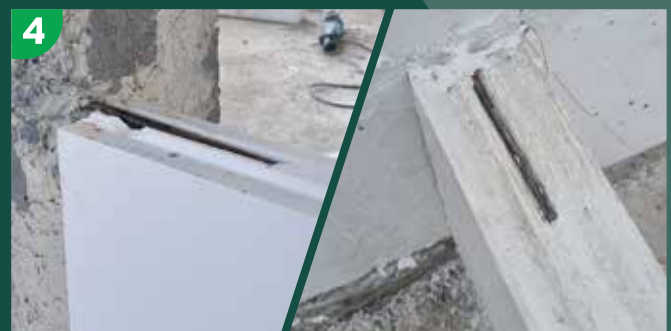
4 เสริมความแข็งแรงด้วยเหล็กหมวดกึ่ง
