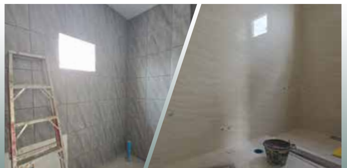
สามารถปูกระเบื้องภายในห้องน้ำได้
