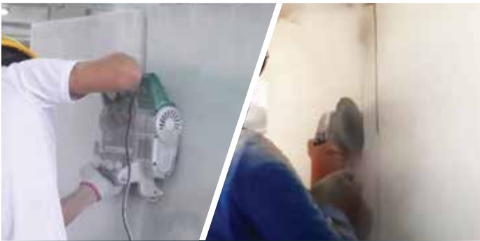
ใช้เครื่องเจาะร่อง หรือลูกหมูกรีดผนังได้
